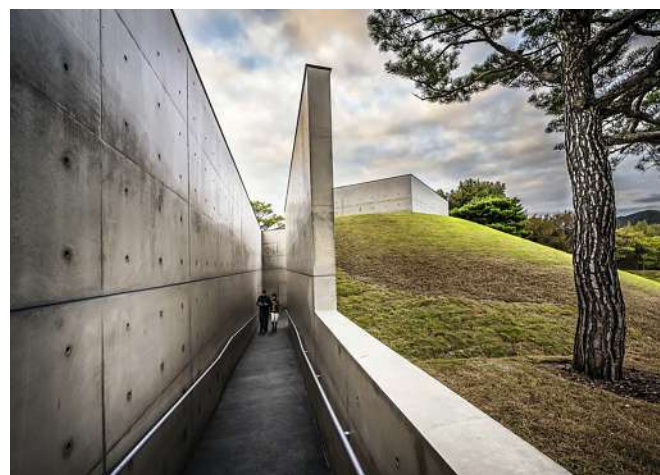
Le musée SAN, suivant la topographie, alterne murs aveugles en béton et ouvertures sur le paysage.
